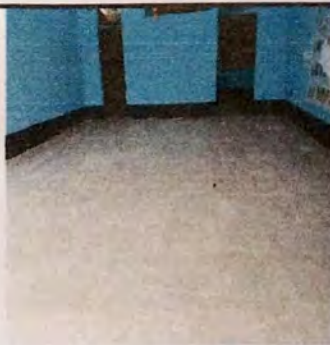
Foto 5: SUSTITUCION DE PISO CERAMICO
