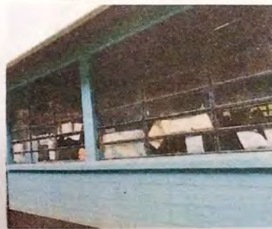
Foto 4: SUSTITUCION DE ESTRUCTURA DE METAL DE VENTANA
