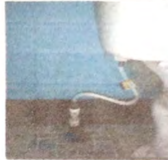
Foto 2: Sustitución de manguera de tanque de un servicio sanitario
