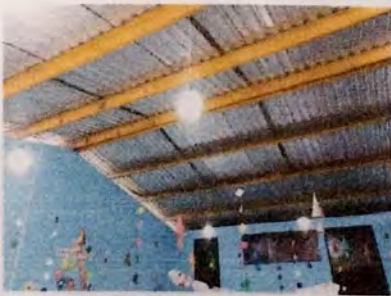
Foto 5: REPARACION DE SISTEMA ELECTRICO
