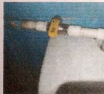
Foto 6: sustitución de llave para mingitorio
