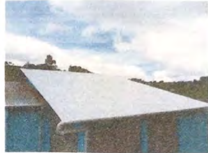
Foto 2: SUSTITUCION DE LAMINA
