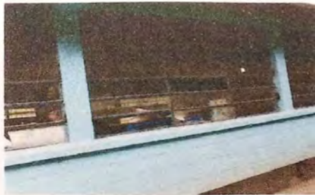
Foto 3: SUSTITUCION DE ESTRUCTURA DE METAL DE VENTANA
