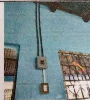
Foto 6: REPARACION DE SISTEMA ELECTRICO
