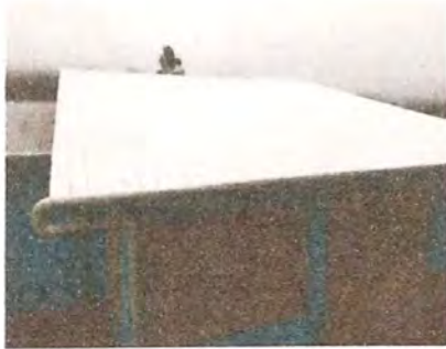
Foto1: SUSTITUCION DE LAMINA
