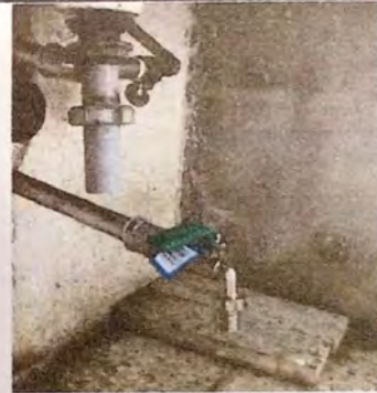
Foto 4: SUSTITUCION DE GRIFO
