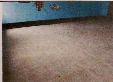
Foto 6: SUSTITUCION DE PISO CERAMICO
