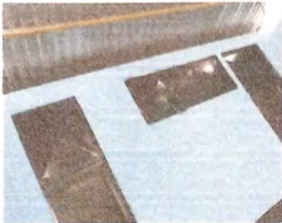
Foto 1: Colocación de lamina lisa a ventanas y reparación de dos puertas de metal
