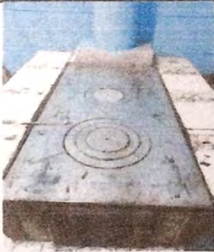
Foto 3: Sustitución de plancha de leña de tres hornillas
